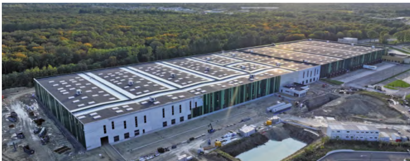
L'extension du bâtiment Dior en cours de construction
